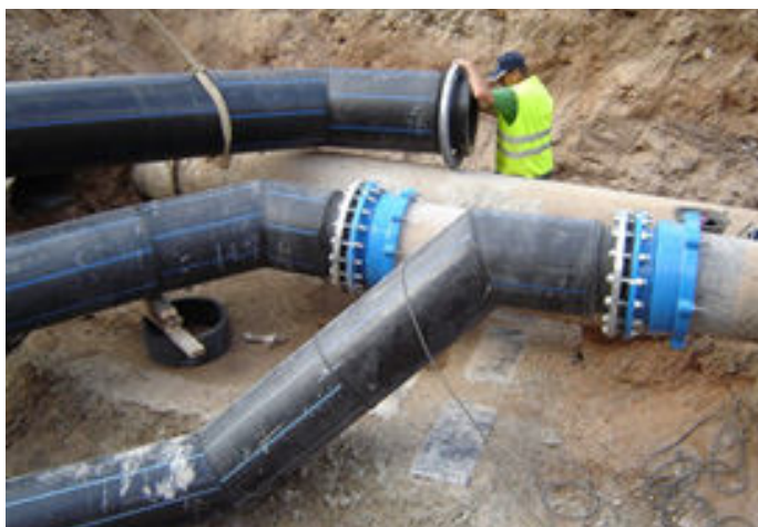
*Rack de tuberías.
