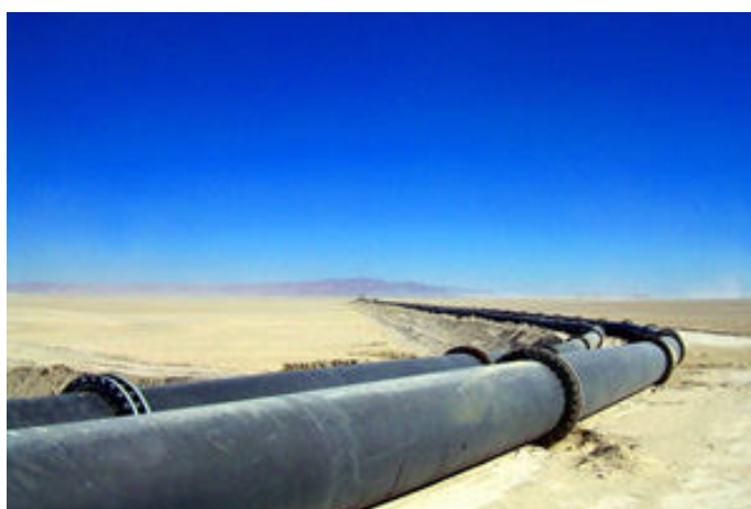
*Transportes hidráulicos relaves, otros.
